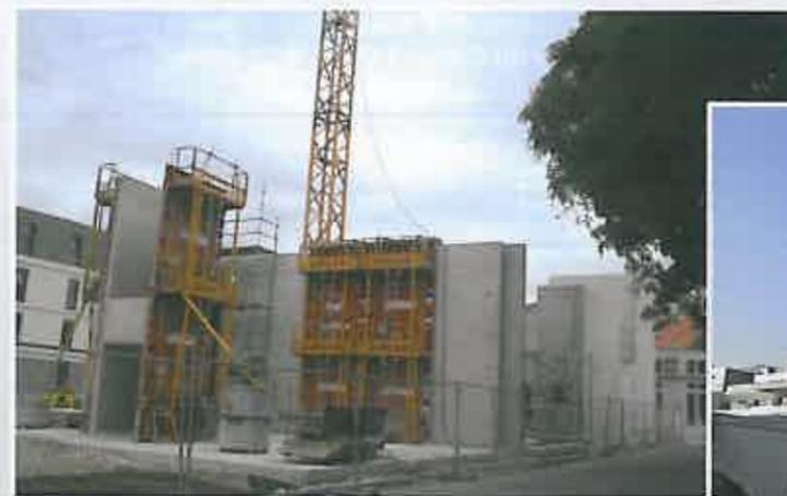
Les murs sont coulés sur place à l'aide de panneaux de coffrage dénommés « banches ». Ces derniers sont déplacés à l'aide d'une grue.
