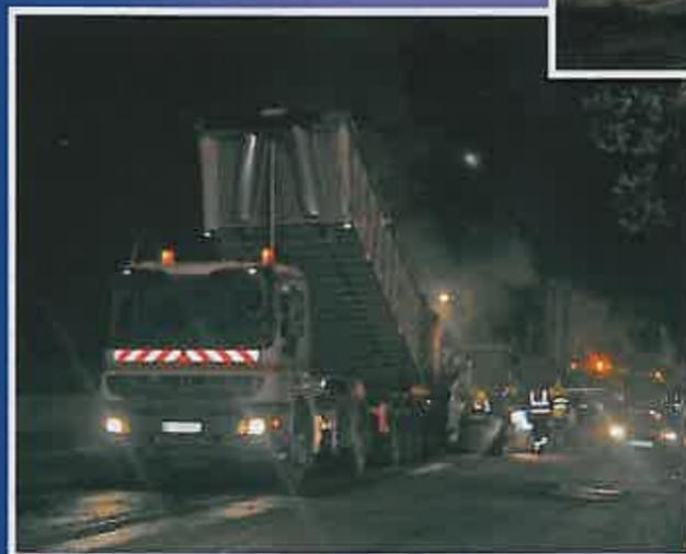
Alimentation en enrobés chauds par semi-remorque dans la trémie du finisseur (engin permettant la mise en place régulière des enrobés), qui est suivie du compactage.
