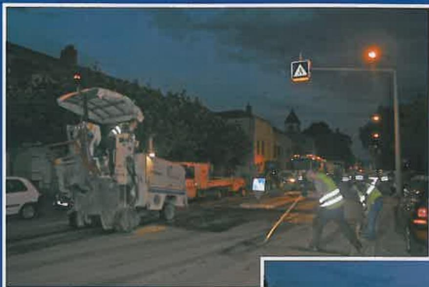
Rabotage mécanique du revêtement existant avec chargement et évacuation par camions.
