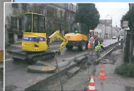
Fouilles en tranchées pour les branchements d'eau pluviale, la pose des fourreaux de l'éclairage public de France Télécom, de la télévision etc.
