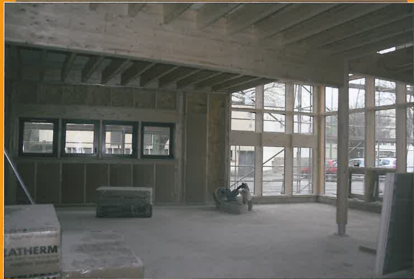
Une vue du hall d'entrée : l'escalier desservant l'étage s'implantera devant les baies vitrées. Une cloison sera construite pour faire un sas entre l'entrée principale et les accès aux salles. Ce chantier devrait se terminer en fin d'année 2013.
