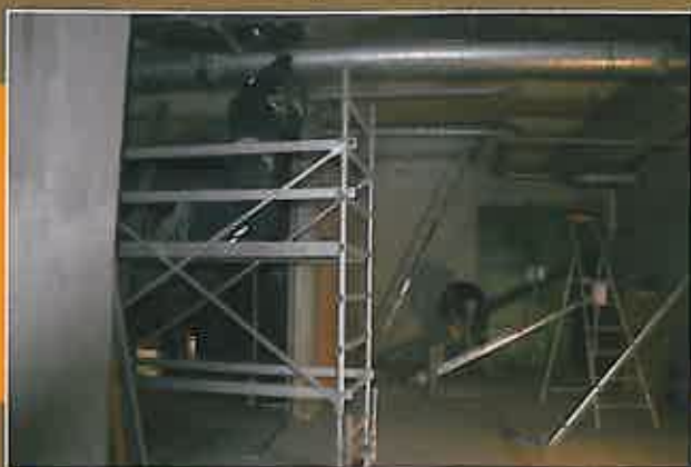
On aperçoit la cage du futur ascenseur. A l'intérieur, les chauffagistes installent les gaines de ventilation, alors qu'à l'extérieur il gèle et il neige.
