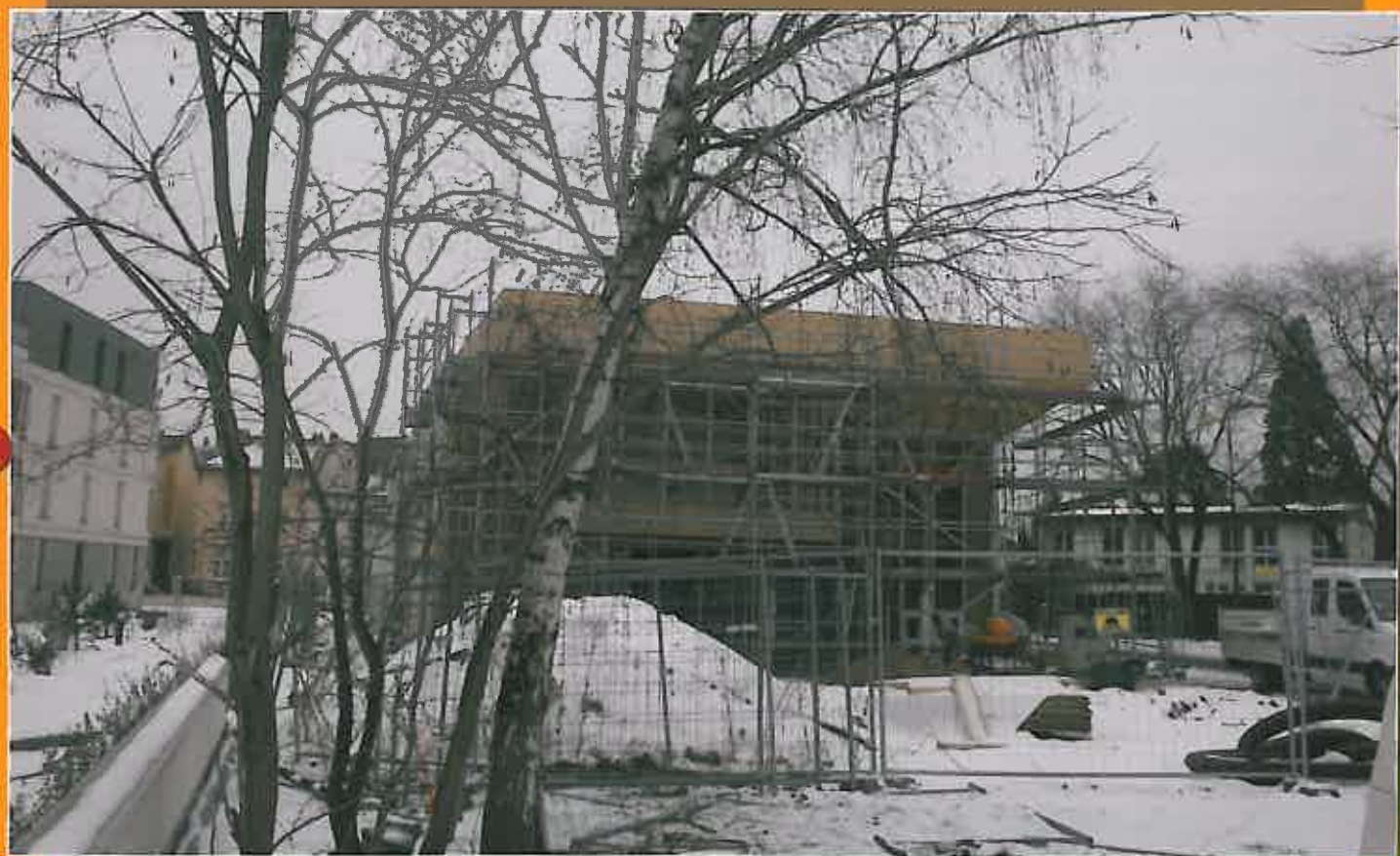
Les échafaudages sont restés en place, mais l'hiver rigoureux a empêché les entreprises de travailler à l'extérieur.
