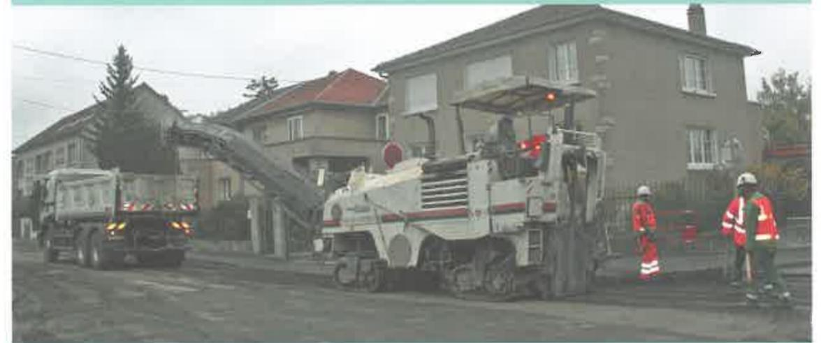
La raboteuse en action grignote les enrobés usagés et les charge dans le camion.
