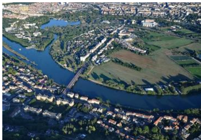
> Vue de Longeville-lès-Metz depuis les coteaux, du village, de l'île Saint Symphorien et de Metz en arrière-plan
