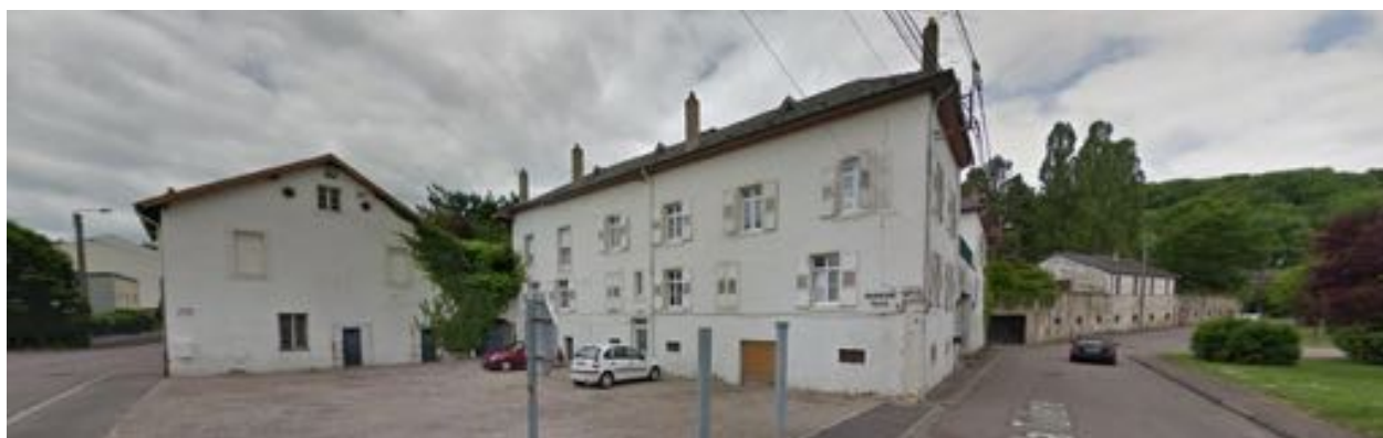
Vue des bâtiments « réhabilitables », à l'angle de la rue des Chenet et de la rue de la Tuilerie
