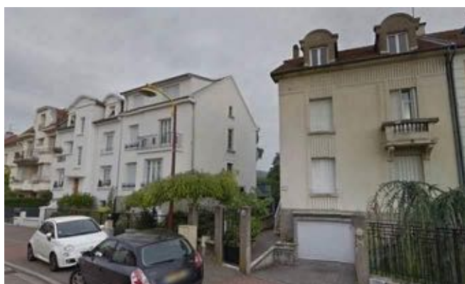
Maisons de ville des années 1930, Rue de la pépinière
