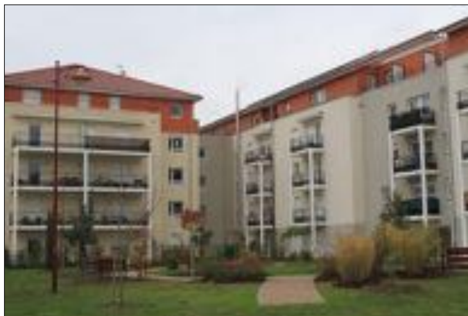
Exemples de logements sociaux en R+4 sur la commune de Woippy au sein de l'agglomération Messine
