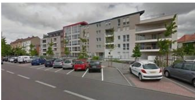
Opération de démolition-reconstruction, Boulevard Saint-Symphorien
