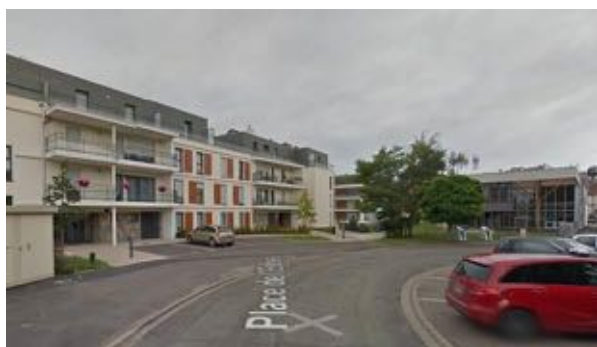
Nouvelle opération de logements collectifs (2010) Place de l'Église
